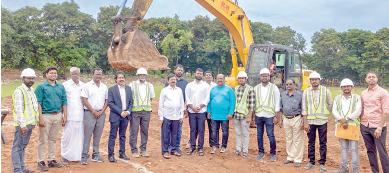
ఉస్మానియా ఆసుపత్రి నూతన భవన నిర్మాణ పనులను ప్రారంభిస్తున్న దృశ్యం
